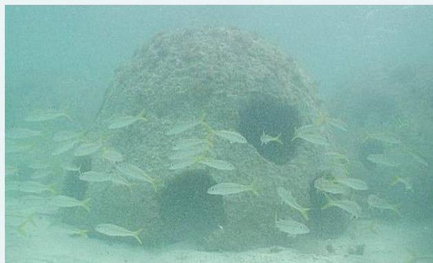
**FIGURA 9** | WAD utilizados para construir un rompeolas sumergido en el Caribe mexicano, específicamente en Puerto Morelos, fuera del área protegida (Silva et al. 2016).
