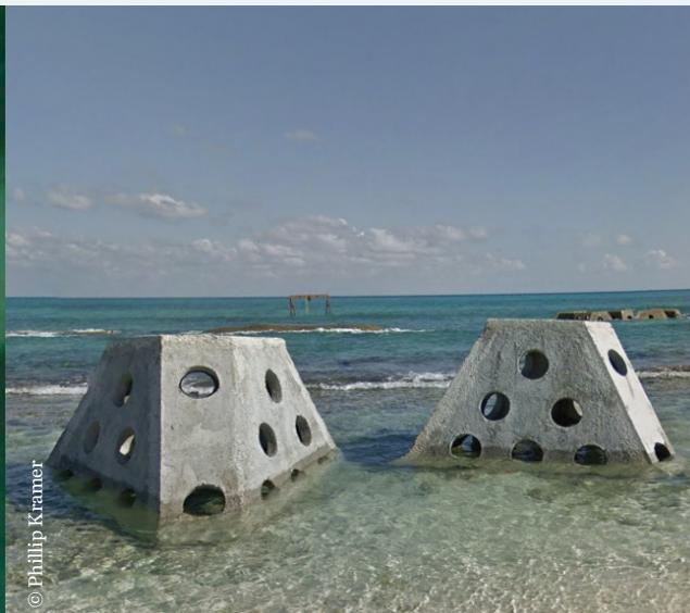
Los Dispositivos de Atenuación de Olas (WAD en inglés) están diseñados en forma de pirámide que puede ser triangular o paralelepípedo (Figura 9). Los WAD demuestran tener mayor eficiencia hidráulica en relación con otros tipos de rompeolas como los tubos de concreto, bolsas de geotextil o muelles tradicionales. Estas estructuras de concreto con agujeros (por ejemplo, WAD, Reef Balls) requieren menos concreto para construir y pueden favorecer el asentamiento de organismos marinos
